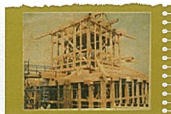
工事中の天守閣
