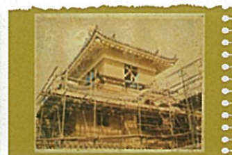
工事中の天守閣
