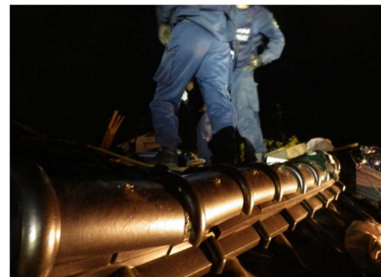
写真 5-6-2 進入箇所付近の状況
