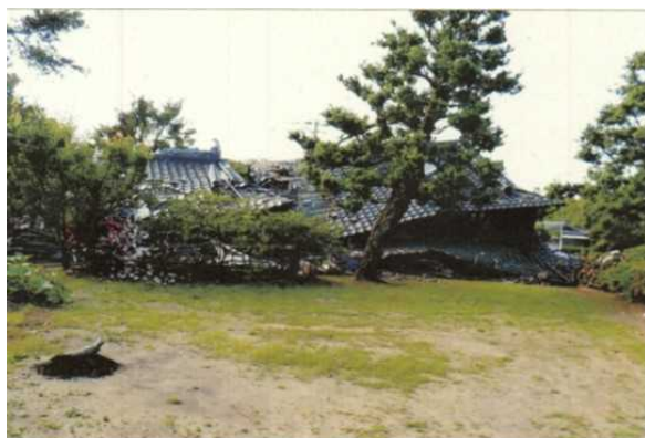
写真 5-10-1 建物倒壊状況 (提供: 現場関係者)
