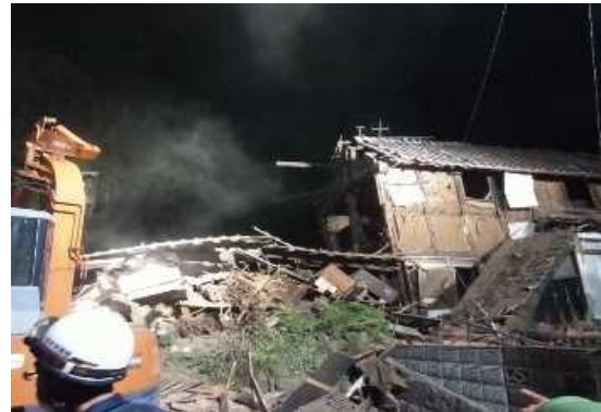
写真 5-9-1 重機との連携による破壊作業の状況
