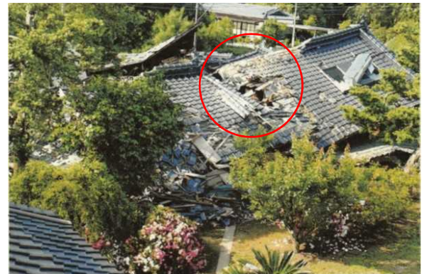
写真 5-10-2 進入箇所の状況 (提供: 現場関係者)
