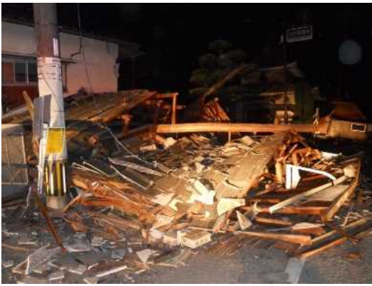
写真 5-13-1 活動後の現場状況
