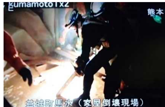
写真 5-7-2 チェーンソーによる床破壊作業の状況
