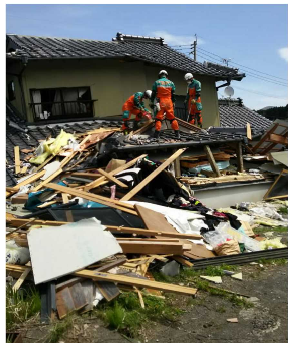
写真 5-38-1 建物倒壊状況
