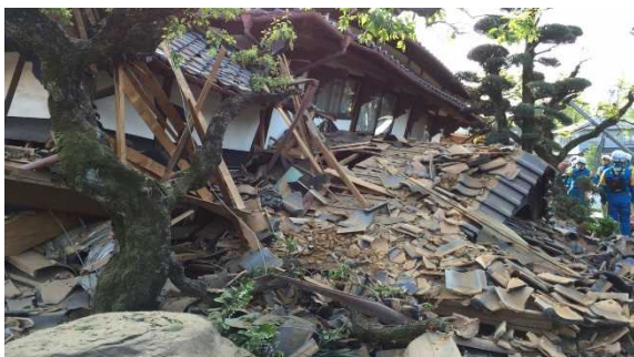
写真 5-36-1 建物倒壊状況 (提供: 長崎市消防局)
