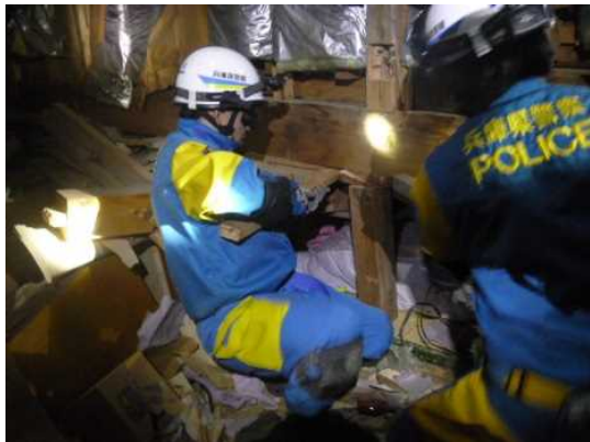
写真 5-28-4 倒壊建物安定化作業の状況
