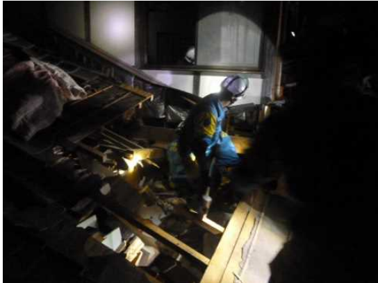
写真 5-28-3 1階からの進入に向けた破壊作業の状況
