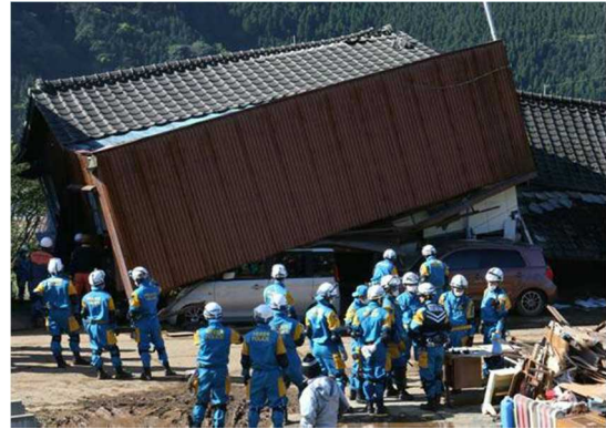
写真 5-37-1 建物倒壊状況
