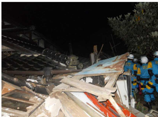
写真 5-14-1 建物倒壊状況
