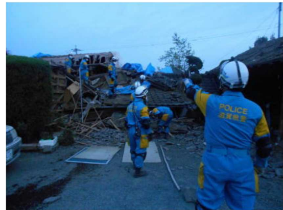
写真 5-26-1 瓦礫除去作業等の状況
