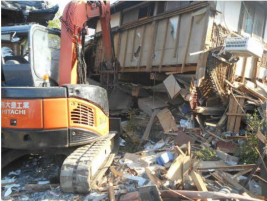
写真 5-27-1 挟まれ・圧迫解除作業の状況
