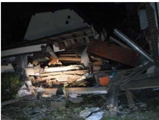
写真 5-20-1 建物倒壊状況
